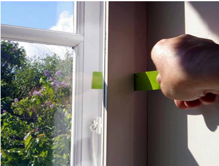
Tjek om vinduet slutter tæt
