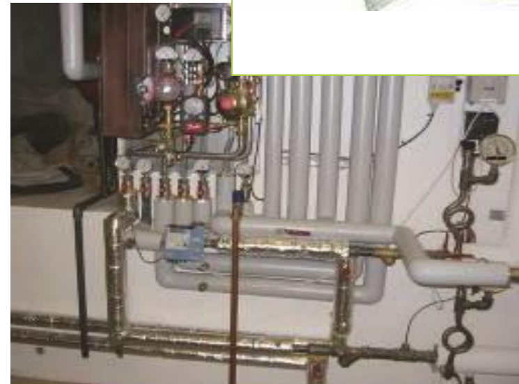
Godt isolerede rør
